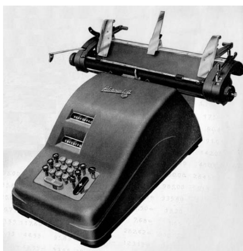
Abb. 13: VEB Büromaschinenwerk Rheinmetall Sömmerda, Modell AES We/33 mit 33 cm-Springwagen, Fertigungsbeginn um 1950
